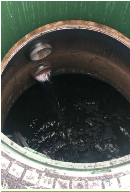
📌 Imagen 12: Depósito de recuperación de aguas destinadas a riego en Colegio Brains.
